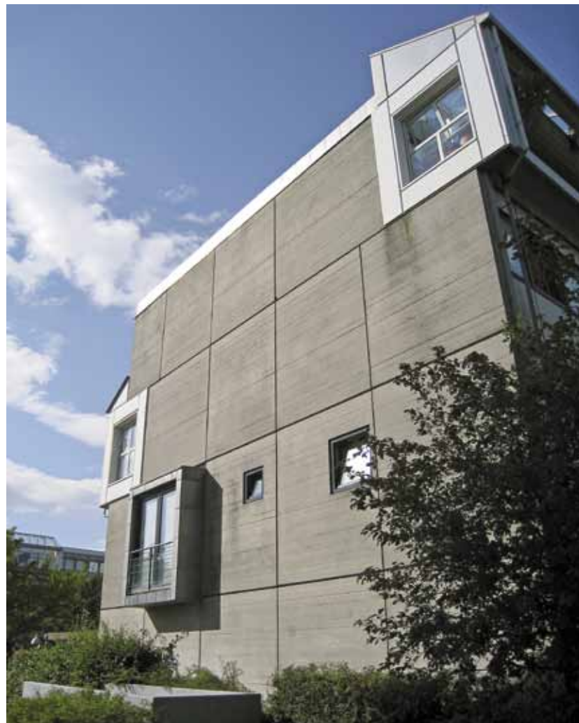
Elementbyggeri, Brøndby Strand 1964-74, tegnet af Svend Høgsbro og Thorvald Dreyer. Foto: Simon Ostenfeld Pedersen 2009.
