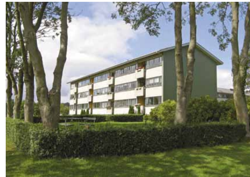
Petersborg i Aabenraa 1966-69, del af Sydjyllandsplanen, Tidligt industrielt byggeri. Foto: Flemming Sørensen.
