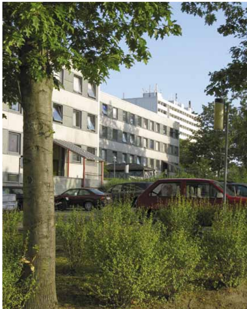
Varbjergparken, Boligforening fra 1972-81, arkitekt Bank Rasmussen. Foto: Flemming Sørensen.
